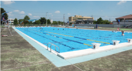
今年度、改修される市民プール
